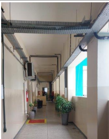
Foto 05 – Condensadoras instaladas na circulação
