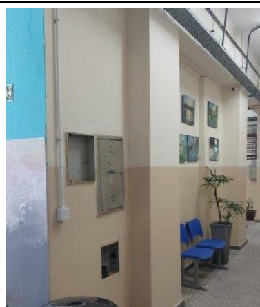
Foto 10 – Quadros de distribuição e caixas de passagem desativados
