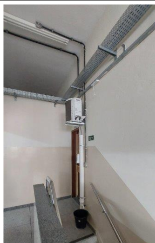
Foto 06 – Condensadoras instaladas na circulação e sistema de dreno.
